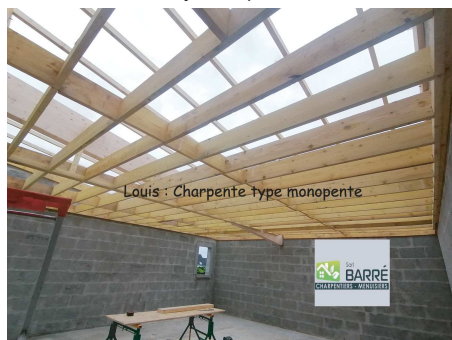
Tom : mise en place de chevrons sur toit monopente
